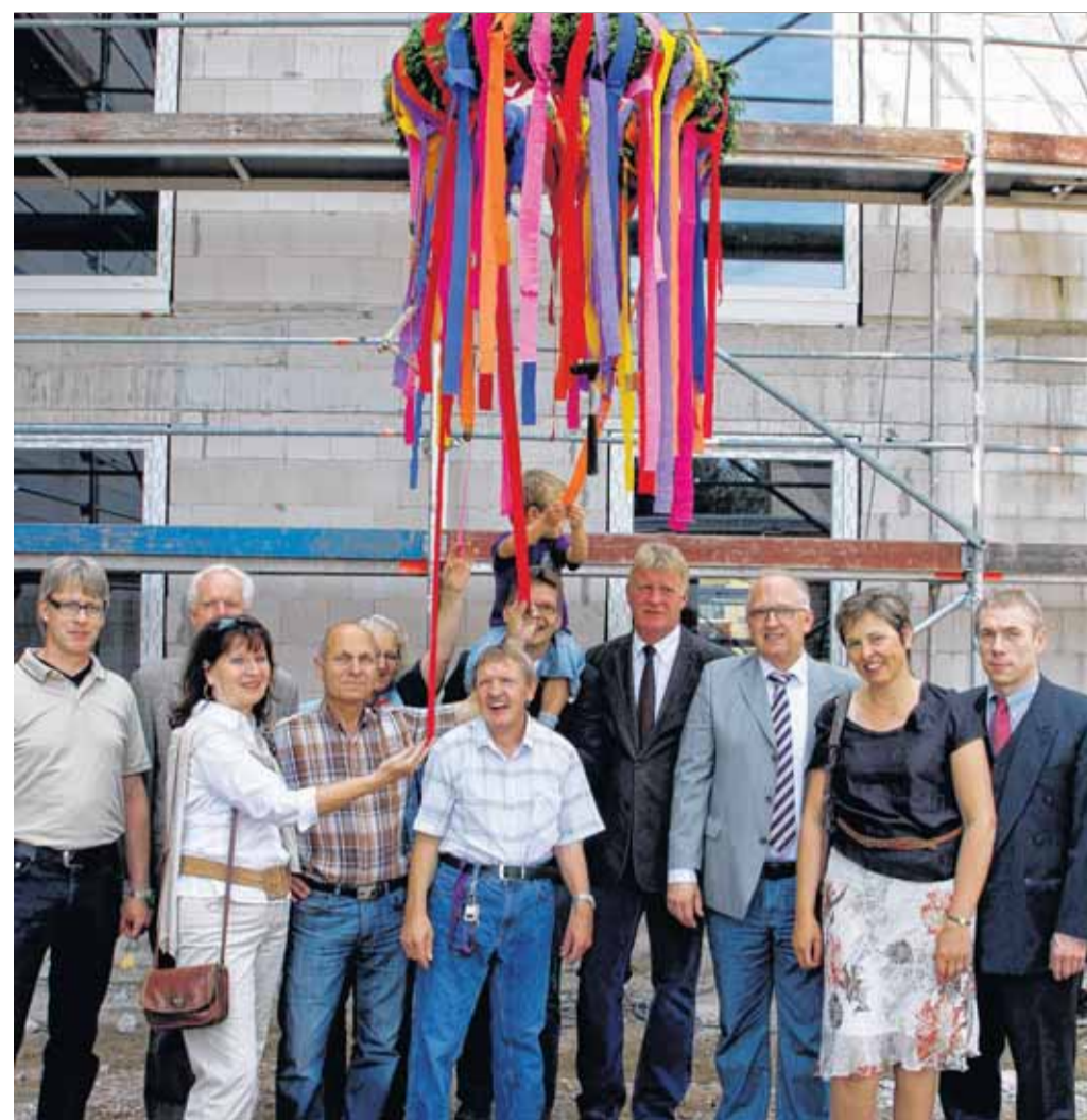
Platz für 50 weitere Bewohner will die Senioreneinrichtung Haus am Berg in Hasbergen schaffen. Am Freitag fand das Richtfest für den Neubau statt. Foto: Klaus Lindemann
