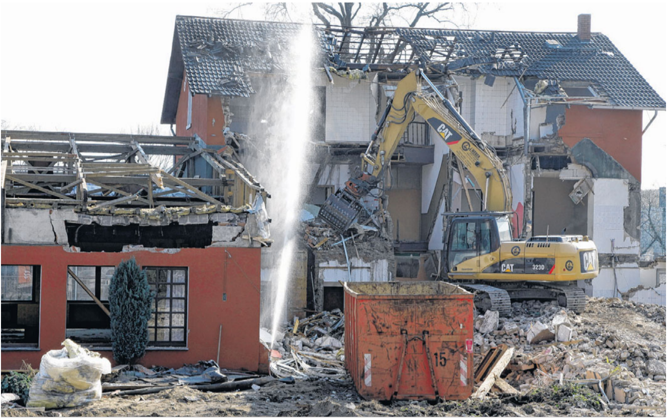
Der Abriss des ehemaligen Gasthofs am Hasberger Bahnhof hat begonnen.
