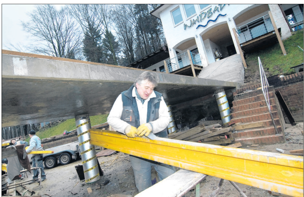
Johannes Scheer und seine Kollegen entfernen derzeit die letzten Schalbretter am neuen Steg im Naturbad.
