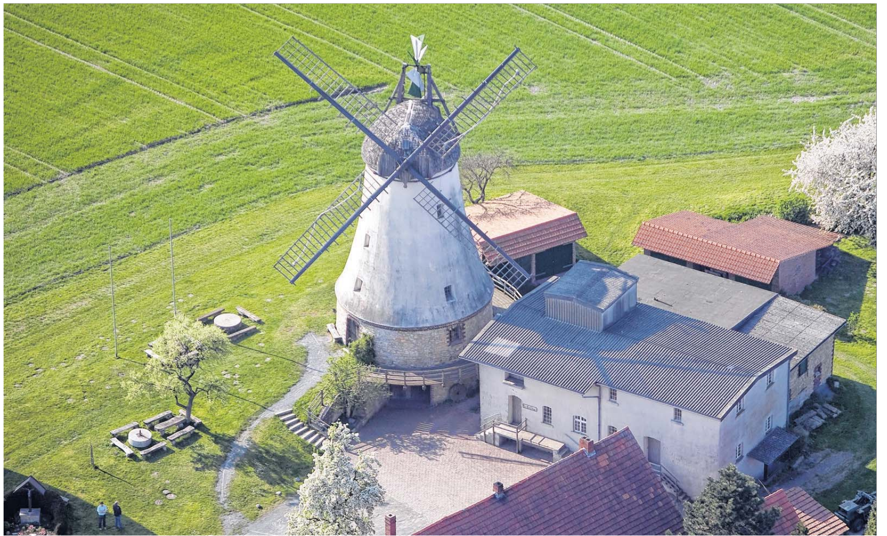
Was schön und alt ist, steht meist unter Denkmalschutz: Das gilt auch für die Galerie-Holländer-Windmühle in Lechtingen. Rechts daneben befindet sich die Motormühle, unten ein rot verkleinertes Wohnhaus. Foto: Gert Westdörp
