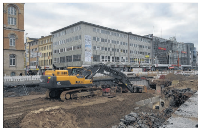
Die Bauarbeiten am Neumarkt erlauben inzwischen für jederman einen Blick auf die Überreste des ehemaligen Tunnels. Limberg-Foto
